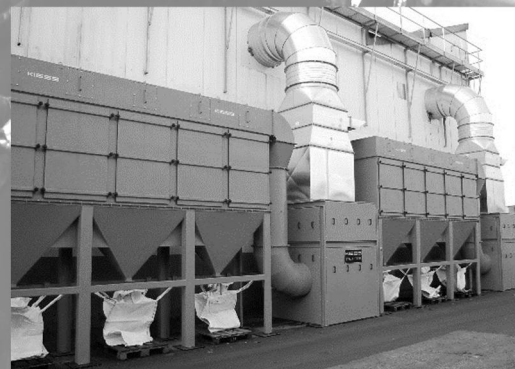
stationäre Filteranlage
