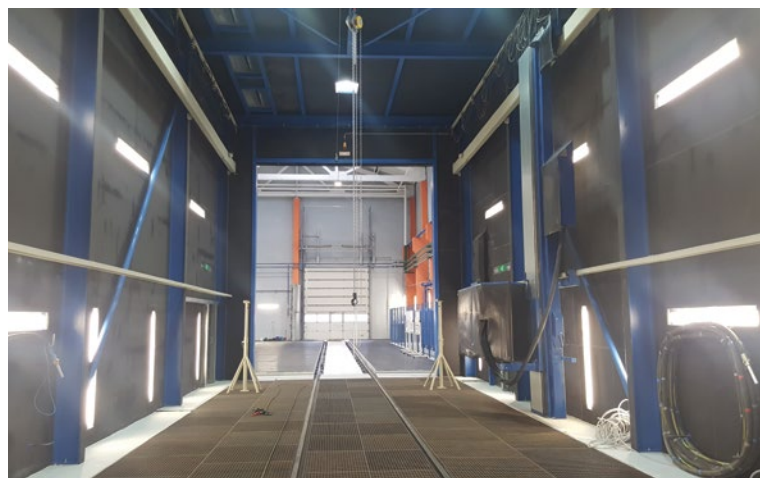
Innenaufbau der Strahlhalle.
